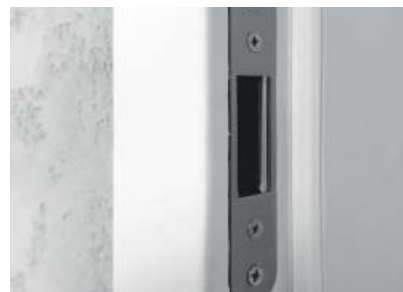
hák magnetického zámku v zárubni
